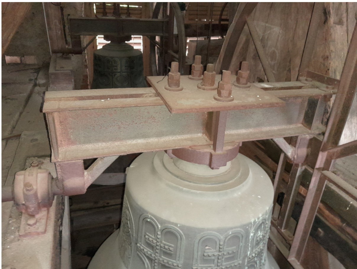
Detail stávajícího uchycení zvonu Cyril
