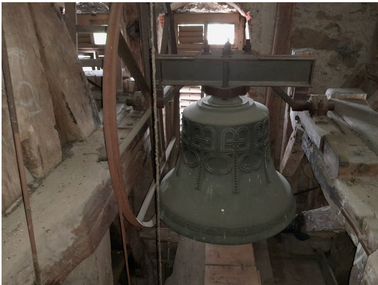
Detail stávajícího uchycení zvonu Marie
